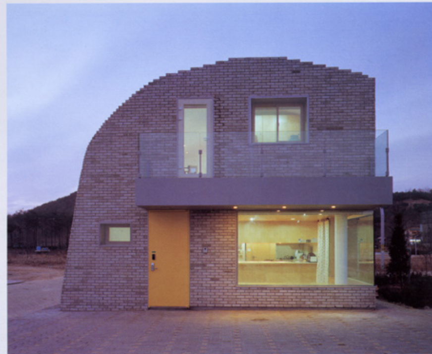
주 출입구 전경
