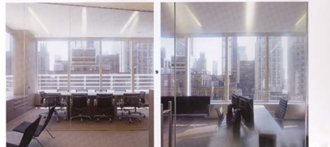
7— Los cerramientos de cristal permiten que desde el interior se goce de una excelente vista del exterior, aunque con el fin de eliminar la visión de cualquier persona u objeto en primer plano desde las zonas de circulación se utilizó "Lumisty", un sistema tecnológico que incorpora una película laminada situada entre paneles de cristal. Esta película desdibuja las vistas y los ángulos que superan los 25° en perpendicular, y está orientada de tal modo que el efecto borroso se produzca en sentido vertical.
